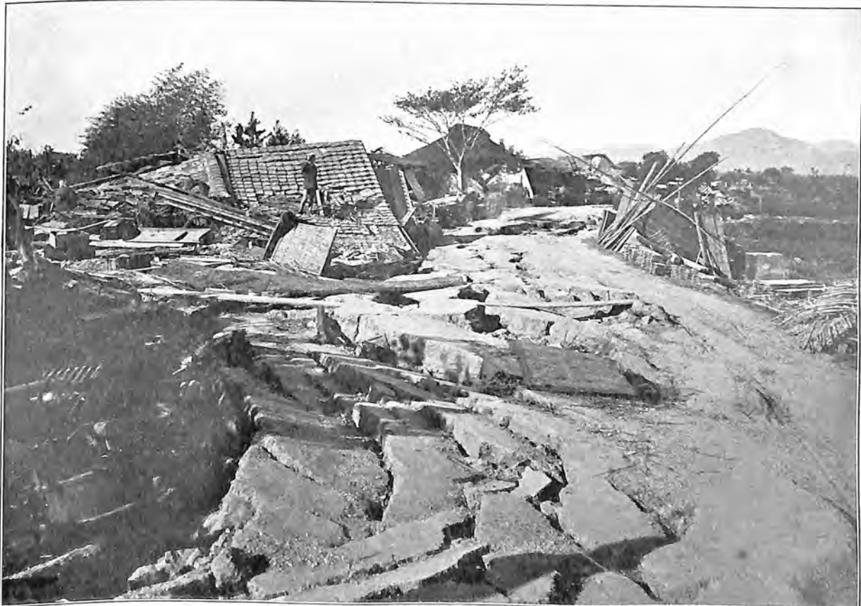
Erdbeben in Zentral-Japan, 1891 Oktober. Hauptherd der Zerstörung. Schollenförmiges Zerbrechen des Alluvialbodens.
