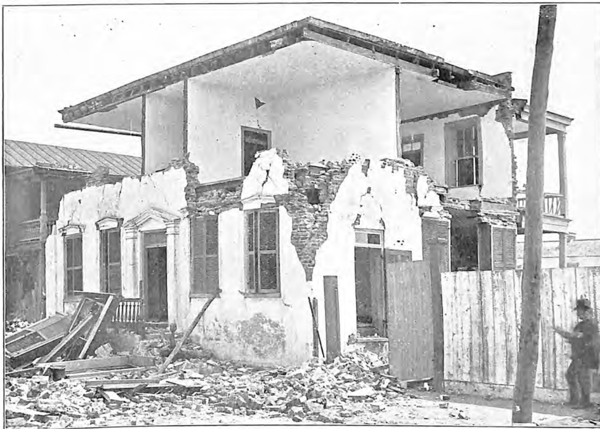
Erdbeben von Charleston 1886. 167 Traddstreet. Die Bewegung war nach SO. gerichtet.
