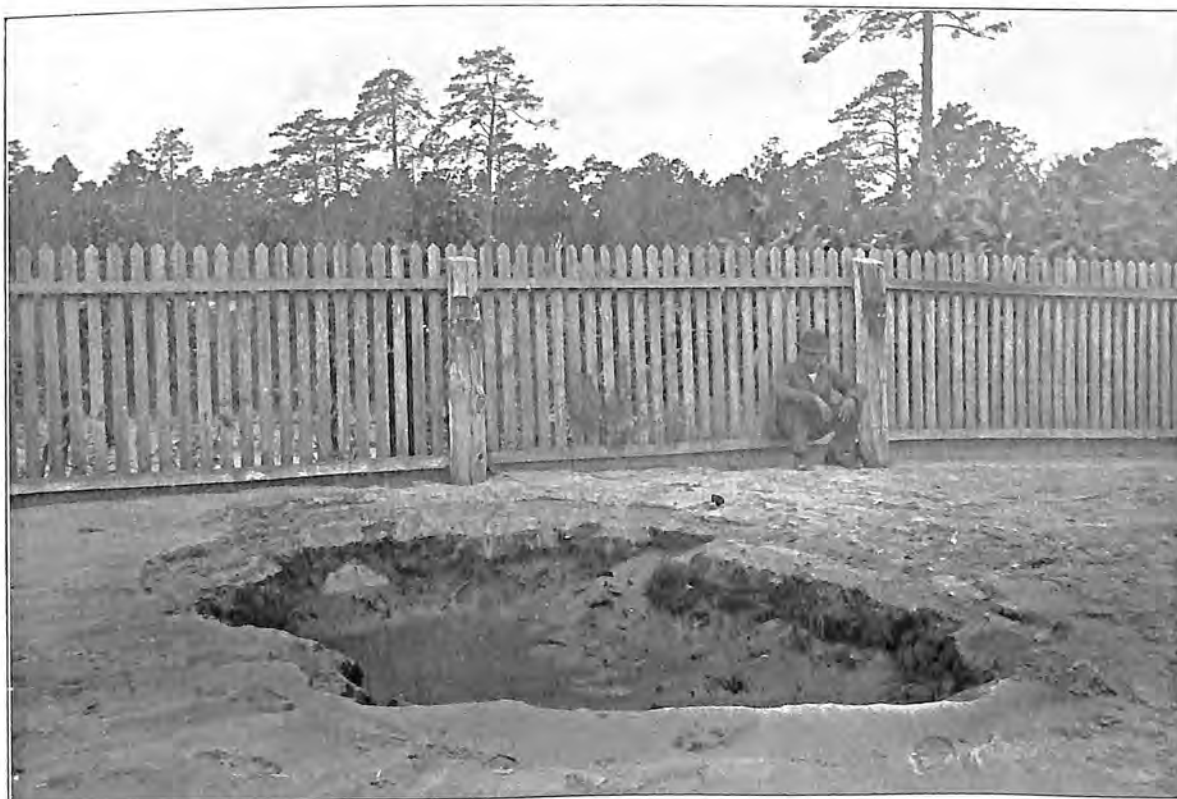
Erdbeben von Charleston 1886. Ten Mile Hill. Trichterförmiger Erdsturz.
