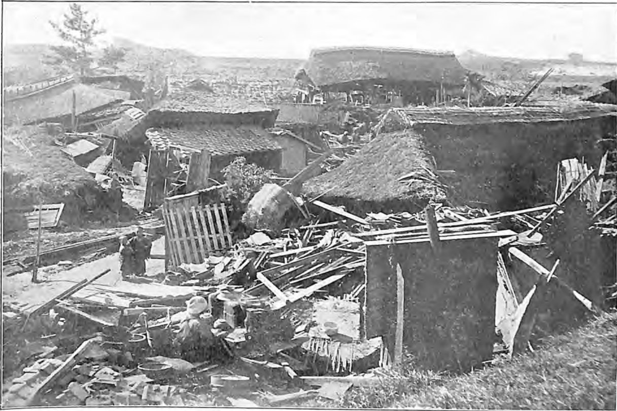
Erdbeben in Zentral-Japan, 1891 Oktober. Zerstörung der Gebäude.
